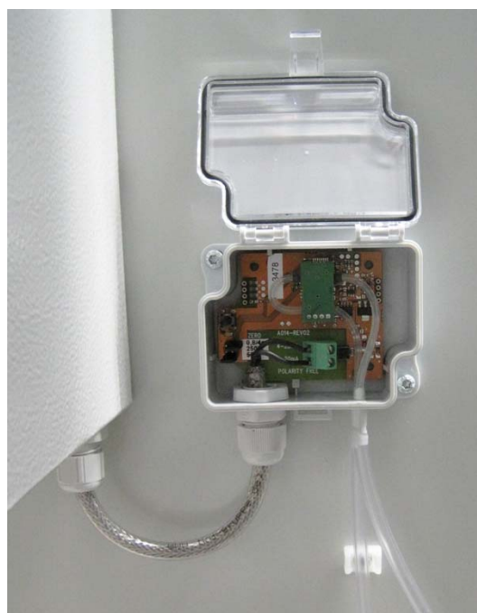
Figure 3.23 Raccordement du DPT (ventilateur d'air à traiter)
