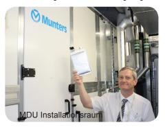
Die spezielle Bauweise der Munters Wärmerückgewinnungseinheit nimmt ca. 100 KW Wärmeleistung auf, während die Anlage in Betrieb ist und setzt diese zur Erwärmung des Trockenraumes ein, der somit keine separate elektrische Heizung benötigt.
