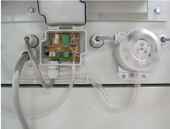
Kuva 3.22 DPT:n liitäntä (regenerointi-ilman puhallin)
