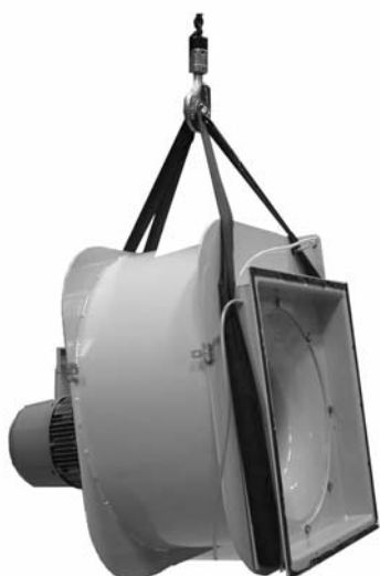
Kuva 3.12 Regenerointi-ilman puhaltimen nostaminen
