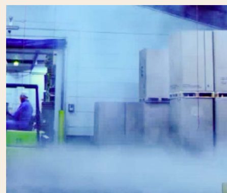
Ijsvorming en mist maken de vloer gevaarlijk.
