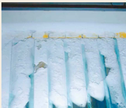
Jään kertyminen lastauslaituriin.
