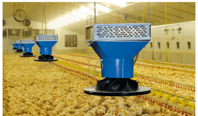
»Heat-X«® vertikale Einbaulage
