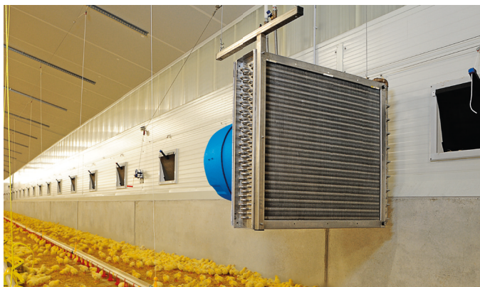
»Heat-X«® horizontale Einbaulage
